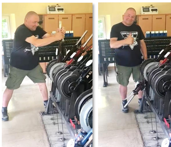
Foto: Volkwin beim Stellen von Weichen- und Signalhebeln auf dem Stellwerk Bertsdorf. Für Ungeübte nicht ganz einfach.
