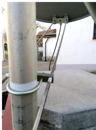
Detailansicht, Gewindestangen zur Einstellung der Elevation
